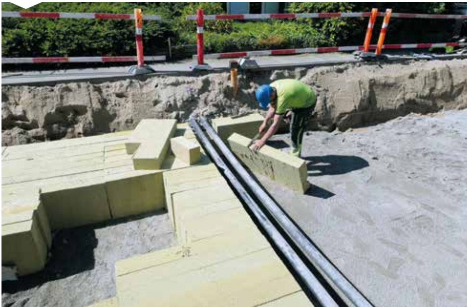
Figur 2: Kabler, ledninger og rør kan tilpasses i stenulds-elementerne, eller der kan laves et tracé, hvor kablerne løber igennem.
